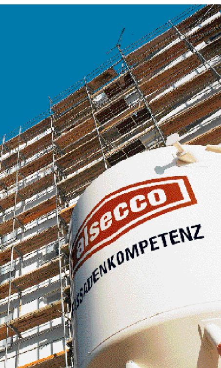
Ein gutes Zeichen für Ihre Baustelle: alsecco Fassadentechnologie ermöglicht rationelles Arbeiten.
