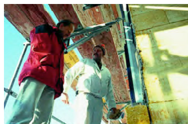
Fassadenkompetenz aus erster Hand: im Schulungs- und Technologiezentrum in Gerstungen und vor Ort auf Ihrer Baustelle.
