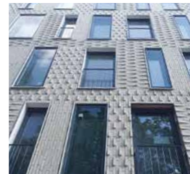
WOHN- UND GESCHÄFTSHAUS IN MÜNCHEN Durch die Anordnung diagonal gesägter Formsteine entsteht ein elegantes Klinker-Relief.
