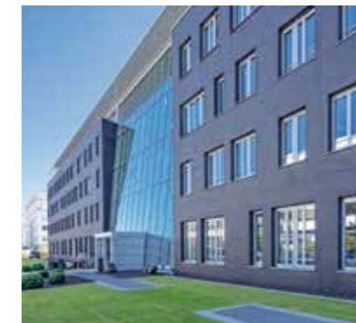
HUMBOLDT-CARRÉ IN LEINFELDEN-ECHTERDINGEN Schwarz geschieferte Klinkerriemchen bilden einen spannenden Kontrast zu den Glaselementen.
