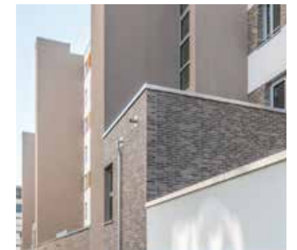
STUDENTENWOHNHEIM IN STUTTART Prägnant im Erscheinungsbild der Fassade ist die Kombination der Materialien Klinker und Putz.
